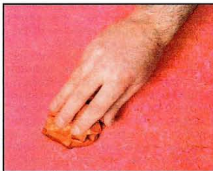
Грубую, четко выраженную структуру покрытия придают с помощью скомканной бумаги, плохо впитывающей влагу. Вполне пригодна для этого упаковочная бумага.
