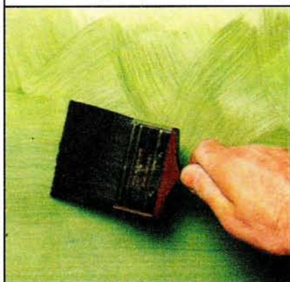
Собственно покрытие наносят кистью. Движениями кисти по диагоналям и вертикали обеспечивается равномерное распределение краски по поверхности.
