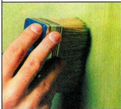
Собственно покрытие наносят кистью. Движениями кисти по диагоналям и вертикали обеспечивается равномерное распределение краски по поверхности.
